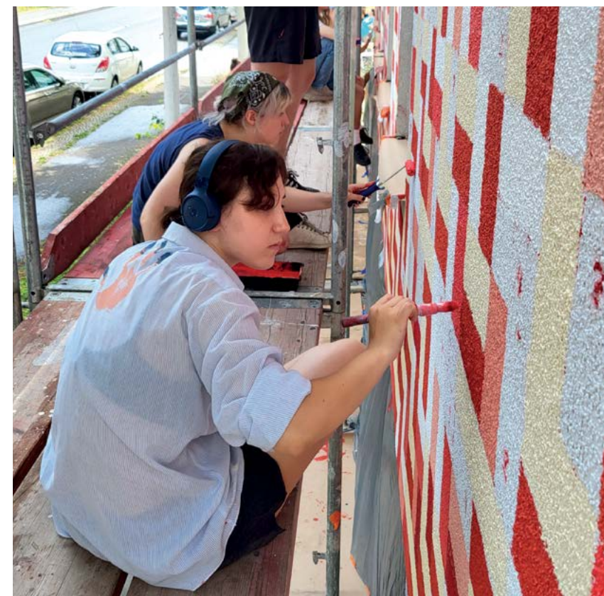
Młodzież podczas prac nad murem
