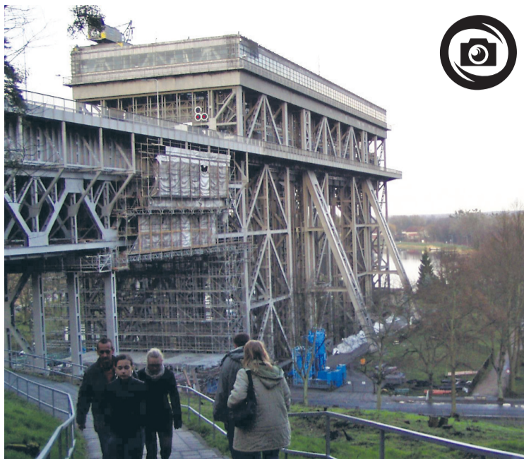
Serpentyna ścieżki prowadzi do platformy widokowej.
