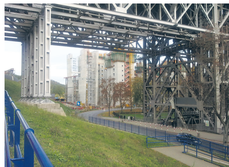
Nowa podnośnia w budowie. Widok z szosy pod podnośnią szarą.
