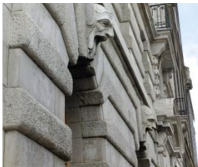
fasada po remoncie
